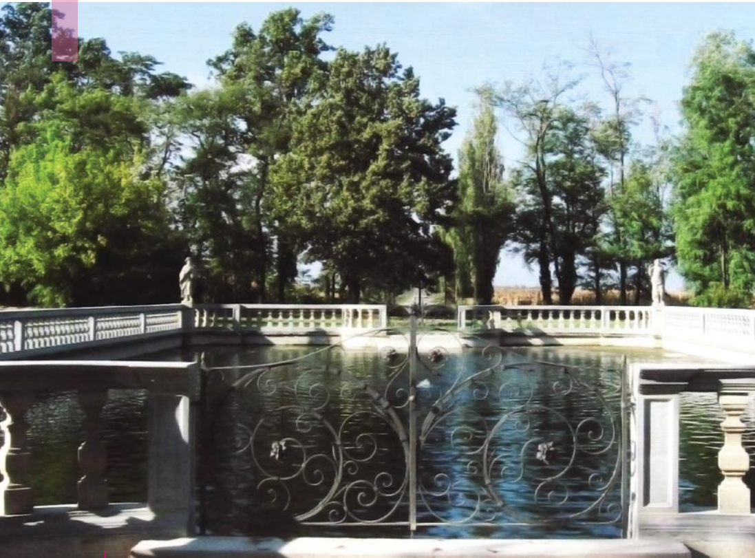
Castel San Giovanni, Palazzo Paveri Fontana: la peschiera dopo il restauro
